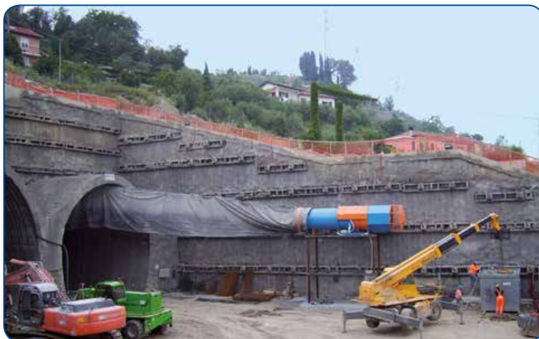
VENTILATORE CENTRIFUGO PER VENTILAZIONE MINIERA IN VALSESIA
